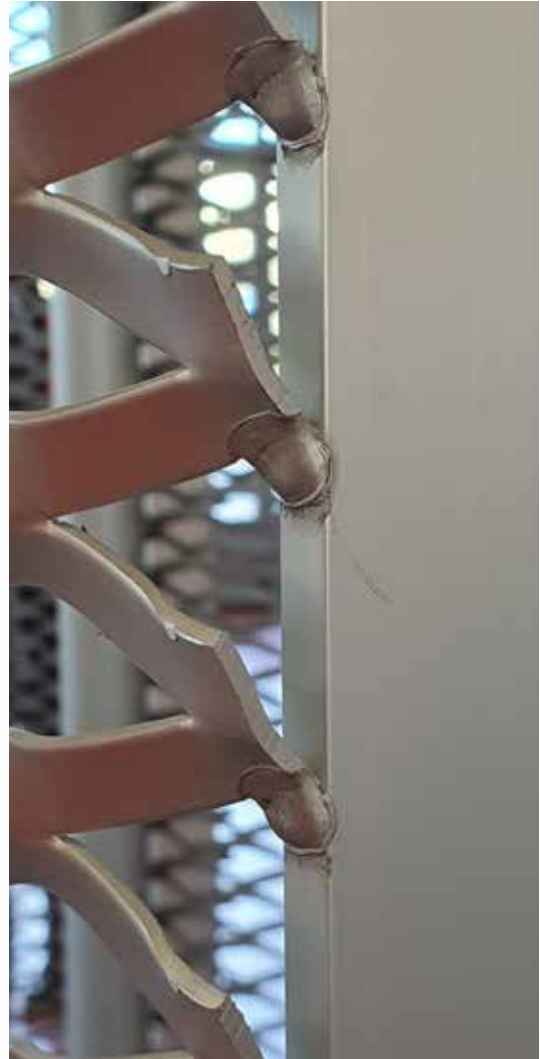
Métal déployé soudé maille par maille sur champ d'un cadre en profil plat
