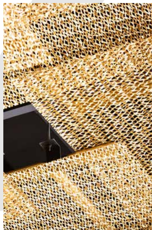
Dalles de plafond en métal déployé froissé superposées
