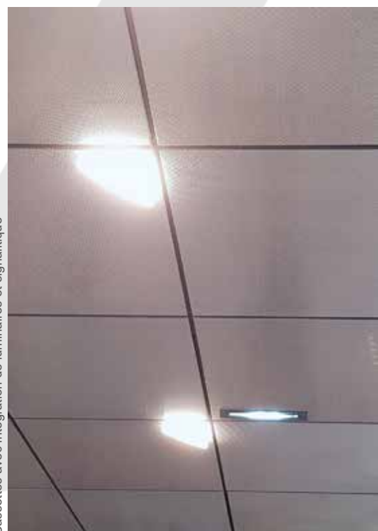
Cassettes avec intégration de luminaires et signalétique
