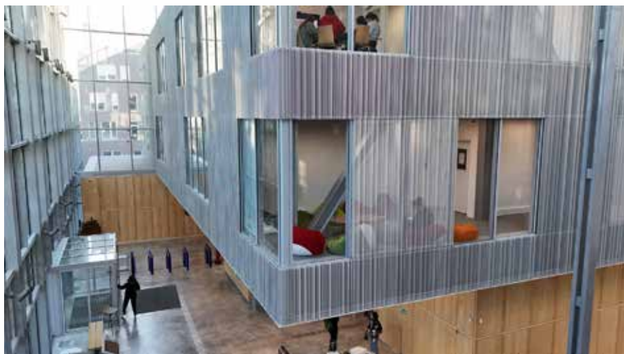
AFR-TAU30 - ST10 x 7,7 x 1,5 x 2 (vide frontal = 50%) - Aluminium anodisé teinte naturelle
