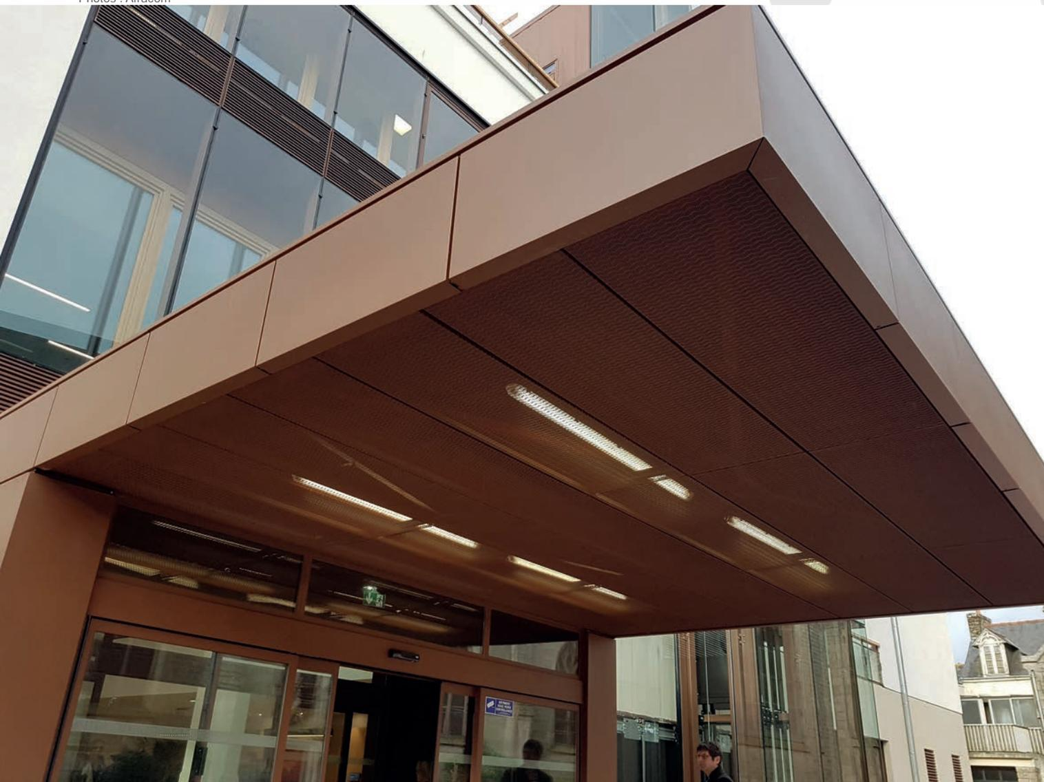
Le choix du bac type D11S avec remplissage en métal déployé gaufré a permis de traiter les plafonds avec des grandes portées et un minimum de raccords
