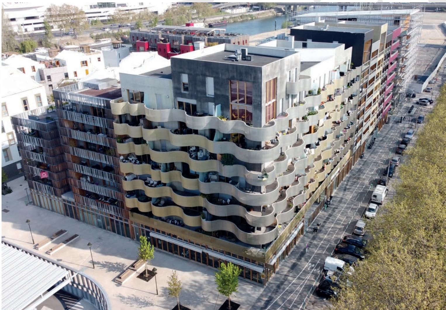
«La conception des larges balcons en sinusoides décalées d'un étage à l'autre assure un bon ensoleillement et crée un jeu subtil de volumes et ondulations en façade»
